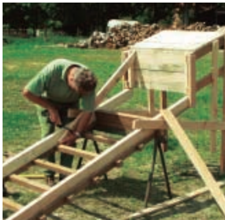
Die hinteren Stützbalken O (1/2) müssen angeschragt unter dem Sitz fixiert werden
