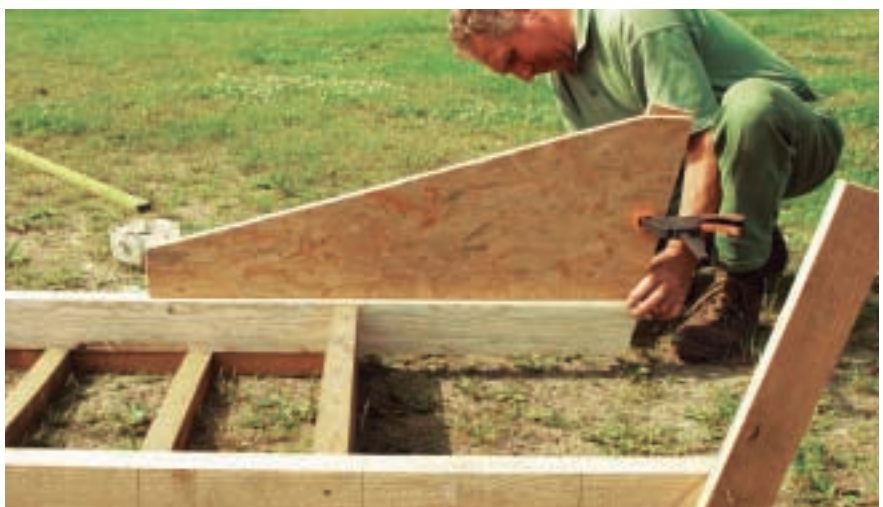
Die Leiterholme werden auf eine lichte Weite von 70 Zentimetern gelegt. Die sieben Sprossen haben zueinander einen Abstand von 23 Zentimetern. Die oberste Sprosse dient zudem als Fußablage. Dazu werden zwischen die Holme zwei Latten fixiert (oben). Die schräg angebrachte Sitzauflage hat einen Winkel von 102 Grad (rechts). Mit einer Schablone (unten) lassen sich beide Hölzer gleichwinkelig anbringen
