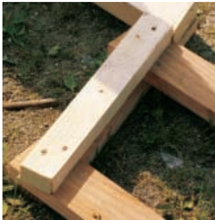
Für das Sitzbrett wird an den Innenseiten des Korbes jeweils das Holz (J) geschraubt
