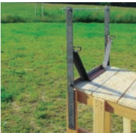
Die Stützvorrichtung am Baum fertigt man aus rostgeschütztem Bandeisen
