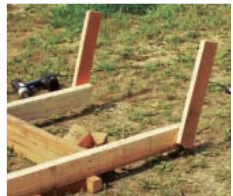
Die Leiterholme werden auf eine lichte Weite von 70 Zentimetern gelegt. Die sieben Sprossen haben zueinander einen Abstand von 23 Zentimetern. Die oberste Sprosse dient zudem als Fußablage. Dazu werden zwischen die Holme zwei Latten fixiert (oben). Die schräg angebrachte Sitzauflage hat einen Winkel von 102 Grad (rechts). Mit einer Schablone (unten) lassen sich beide Hölzer gleichwinkelig anbringen
