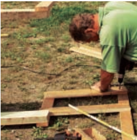
Ein Seitenteil des Ansitzkorbes – hier das Holz (F) der Rückenlehne – wird gefertigt
