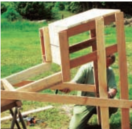
Die beiden Stützen M (1/2) werden von außen an Korb und Holme genagelt
