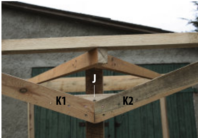
Dachträger von vorne: Die Latten müssen passend angeschrägt und auf das Dreieck J geschraubt werden.
