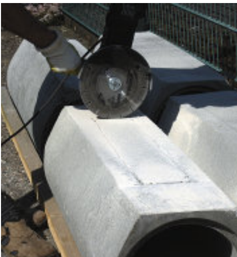
Um das Wild später entnehmen zu können, wird das Rohr auf der Oberseite aufgeflext.
