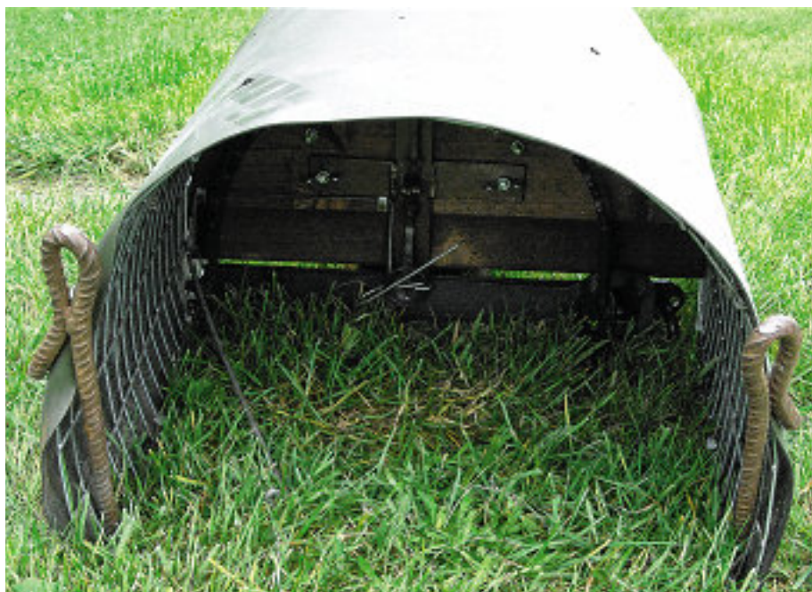
Sicher ist sicher: Natürlich muss das Eisen vor unbefugtem Zugriff geschützt werden. Hier übernimmt ein Drahttunnel mit Sicherheitsauslöser diese Aufgabe.
